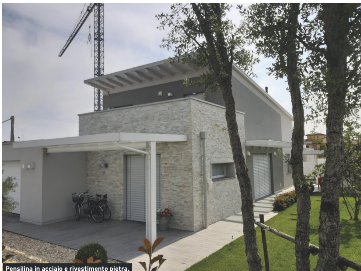
Pensilina in acciaio e rivestimento pietra.
